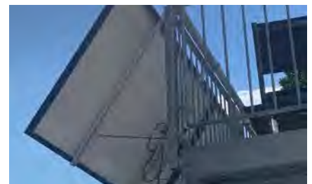
Abb 10 — Das angewinkelte Modul am Balkon. Die Aluprofilschiene wurde mit Stoppmuttern am Modulrahmen befestigt. Zusätzlich wird das Modul mit Stahlseilen gesichert. •
