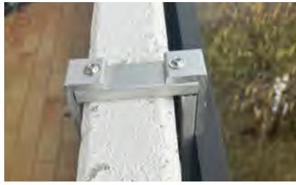
Abb 12 — Da man in den Balkon nicht reinbohren darf, sollten die Seiten des Hakens ausreichend lang sein. •
