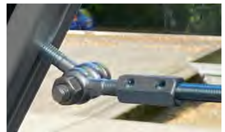
Abb 7 — Die Gewindestange wird über eine Hülsenmutter mit einer Augenkopfschraube verbunden. •
