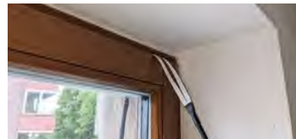
Abb 8 — Statt einer Bohrung kann auch ein Flachkabel verwendet werden. Foto oben: Sonnenrepublik, unten: Privat •
